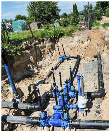
Vystrojení armaturní šachty v ulici Okružní
