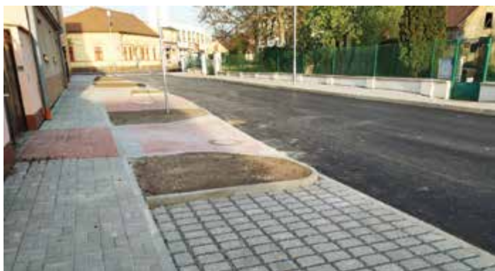
Rekonstrukce ulice 28. října
